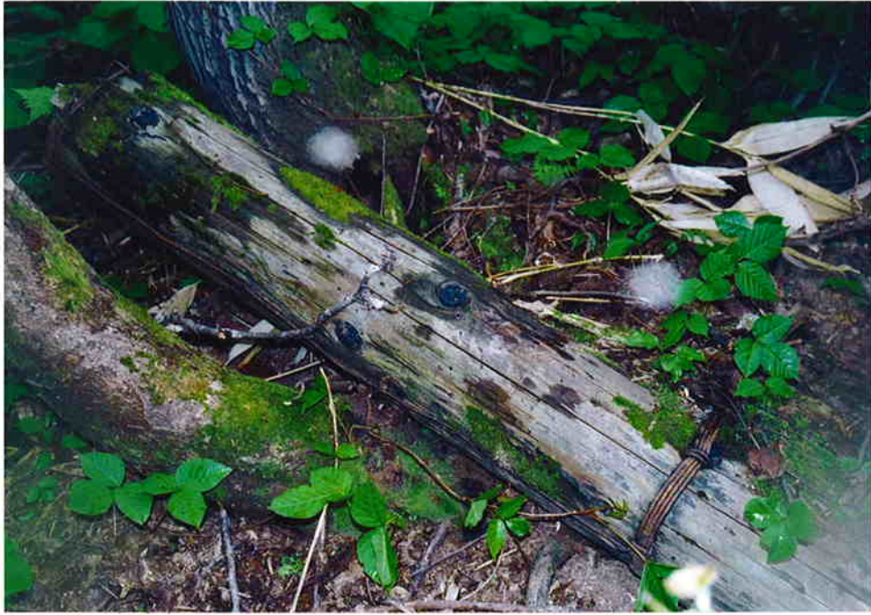
根本部分の節はタールで防腐処理 2本の短柱で本体下部を番線で挟み補強
