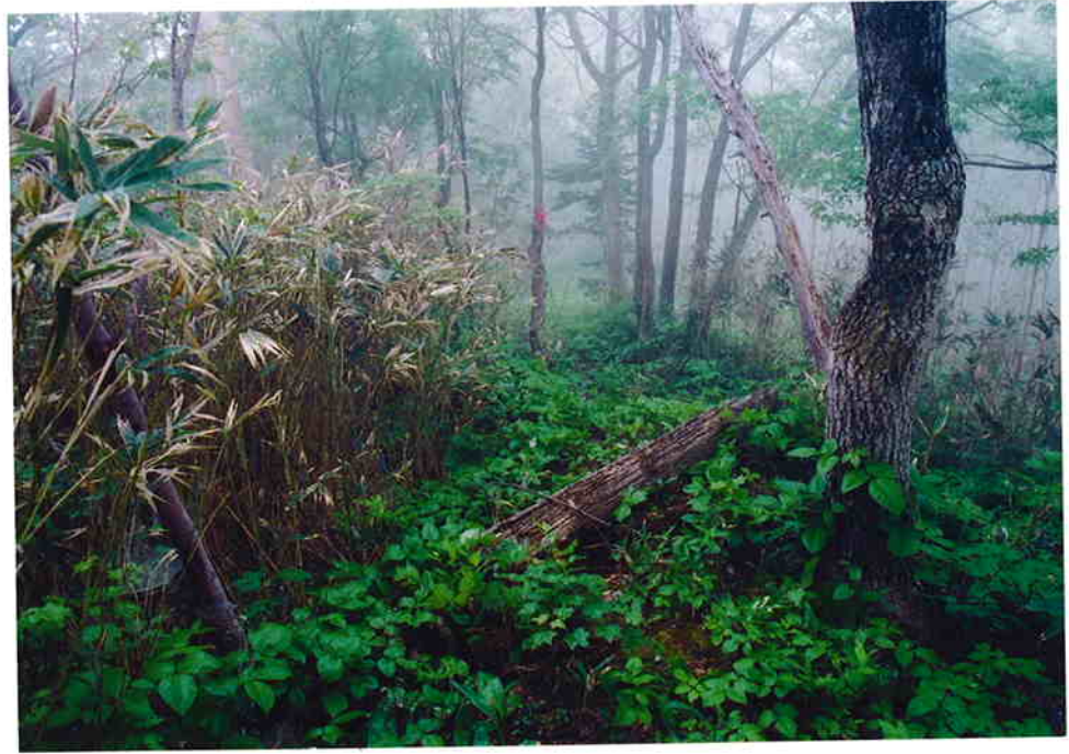
③. 植林刈り払い地の端部に沿った所で発見 腐食進行
