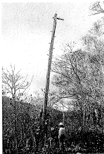
現存 道沿いに点在する電信柱。100年以上前に増毛山道に電話線が敷設されたことを今に伝える
